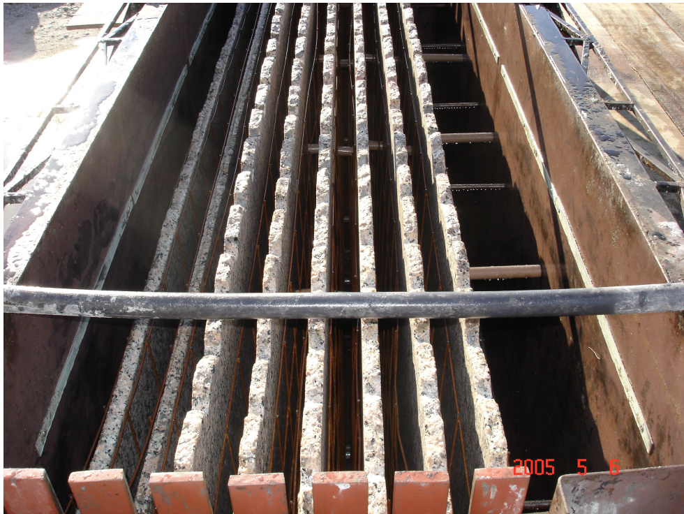
Forma do produto com as placas instaladas pronta para a concretagem
