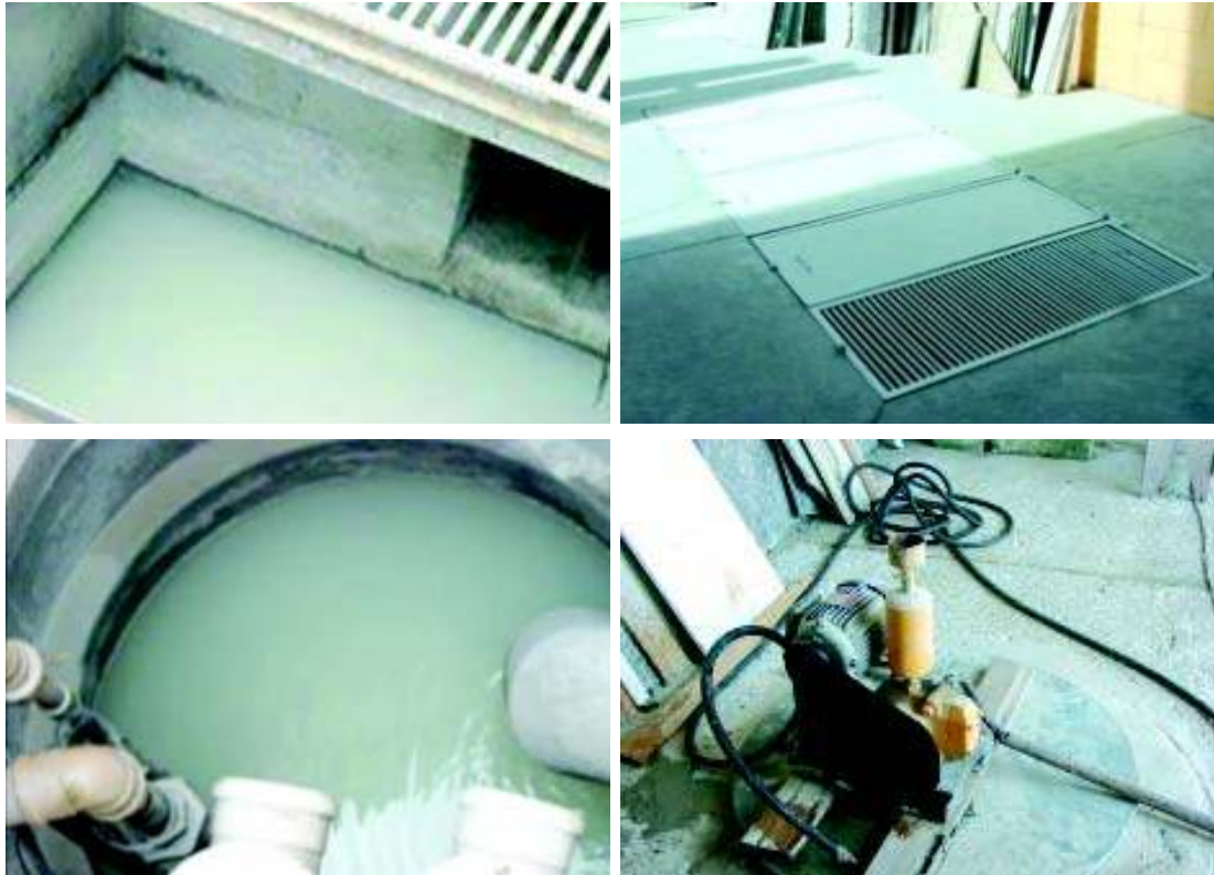
▲ Fig. 12: Partes componentes do sistema de decantação
