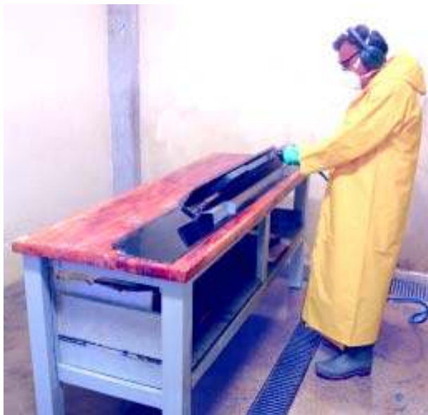
◀ Fig. 11: Escoamento de água por canaletas com grelhas no piso
