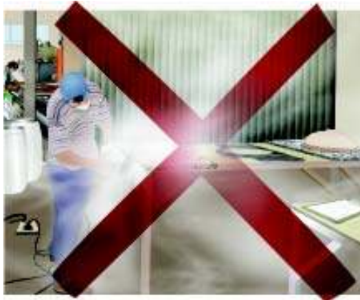
◀ Fig. 3: Situação de acabamento a seco
